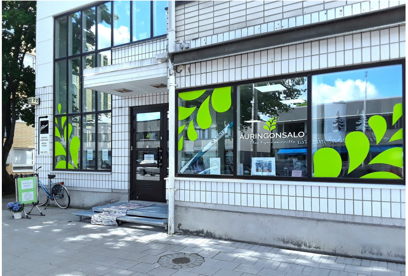
Auringonsalon sisäänkäynti sijaitsee Salon keskustassa, Turuntielle. Toimitilamme ovat toisessa kerroksessa. Rakennuksessa on hissi.
